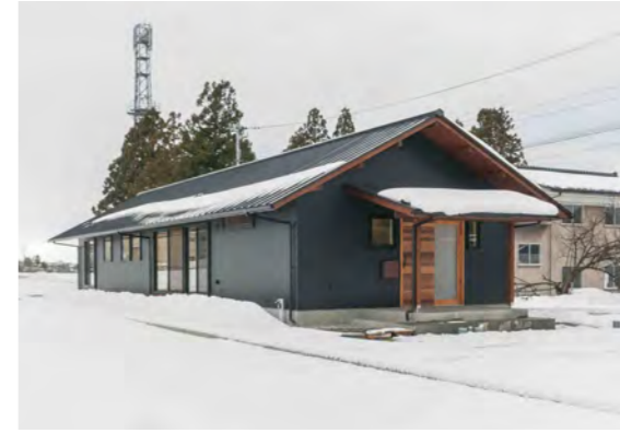
T邸は施主と各工事業者が直接契約を結ぶ「CM分離発注方式」を採用。各工事にかかる金額や進捗が把握でき、納得しながら家づくりを進めることができたという
